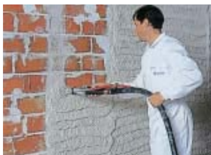
Sadrová kašovitá hmota sa pod tlakom nanáša na omietanú stenu či strop (žiadny odpad).
