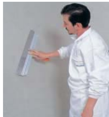
Konečná úprava povrchu hladením
