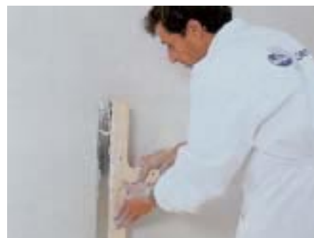
Konečná úprava povrchu hladením
