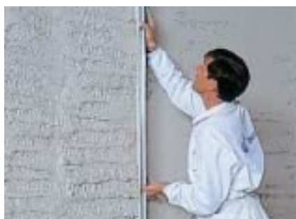
Po nanesení sa omietka ihneď nahrubo zarovnáva hliníkovou latou.
