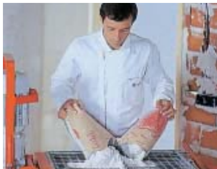
Stroj na omietanie zmiešava suchú sadrovú zmes s vodou a vytláča kašovitú hmotu do hadice.
