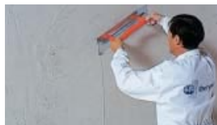
Po zavädnutí sa vyrovnáva (zrezáva) do roviny nerezovým hladítkom.
