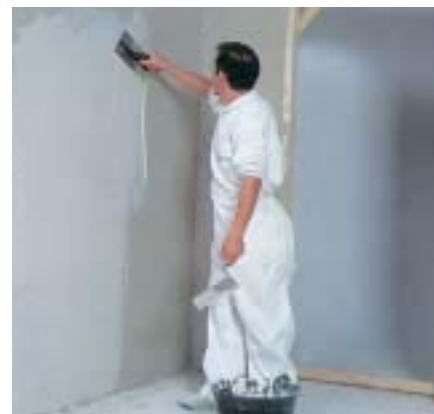
Úprava stierky pred vyhladením
